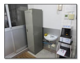
左に外用白衣ロッカー、右にアルコール噴霧器、 その左に自動水洗を設置。写真の左奥が、飼養保 管施設兼動物実験室。
