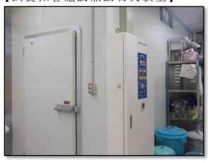
写真の左が飼養保管施設兼実験室の扉で、その 右側にある制御盤で、庫内の温度、湿度、照明 等を制御。さらに、異常時の警報発報装置と室 外の警告灯を設置。
